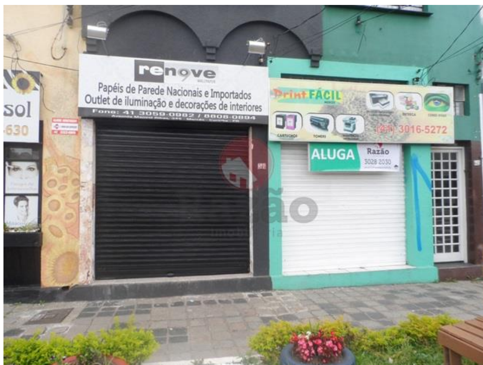
Figura 37. Fachada do ponto comercial do Bigorriho Fonte: Imobiliária Razão (2015)
