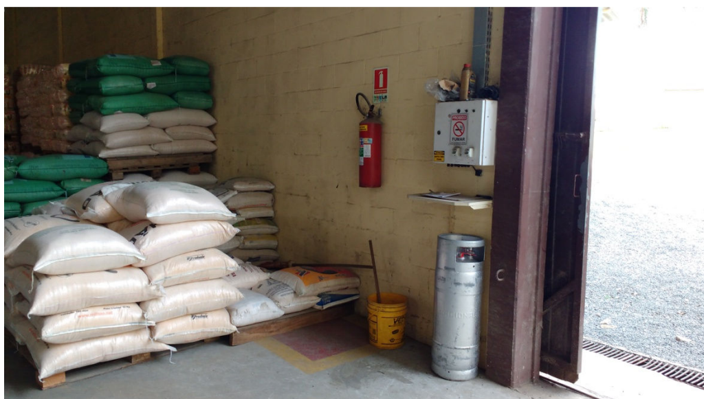
Figura 14 - Obstrução de espaço próximo ao extintor Fonte: A autora (2016).
