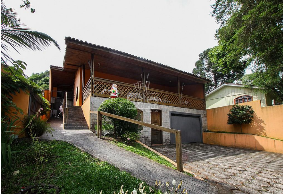
Figura 5 – Fachada da Casa Comercial
