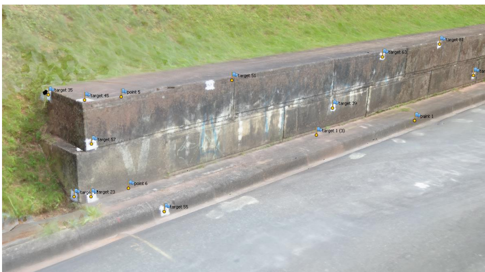
Figura 22 - Alvos codificados detectados pelo software Photoscan ®
