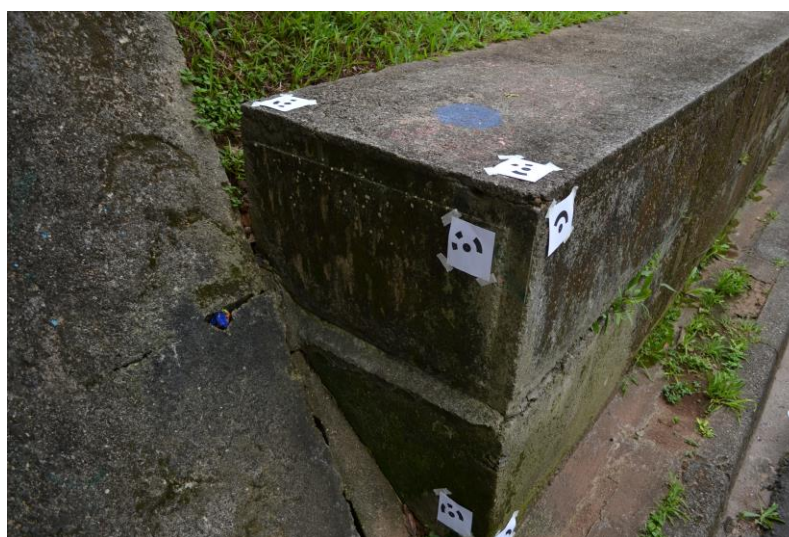
Figura 21 - Alvos codificados fixados na superfície da bancada de concreto Fonte: Os Autores, 2014
