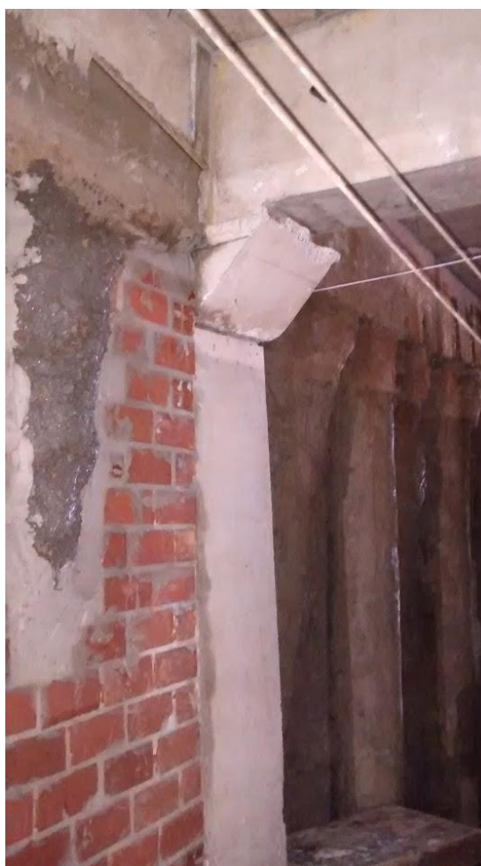
Figura 22: Pilar executado.
