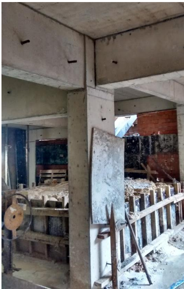
Figura 28: Pilar executado.
