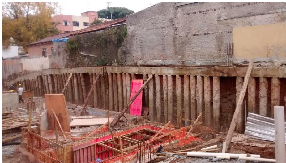
Figura 08: Estágio da construção no início do estudo.
