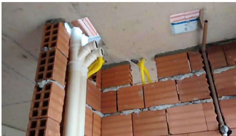
Figura 16: Detalhe da coluna de esgoto na lavanderia 2.
