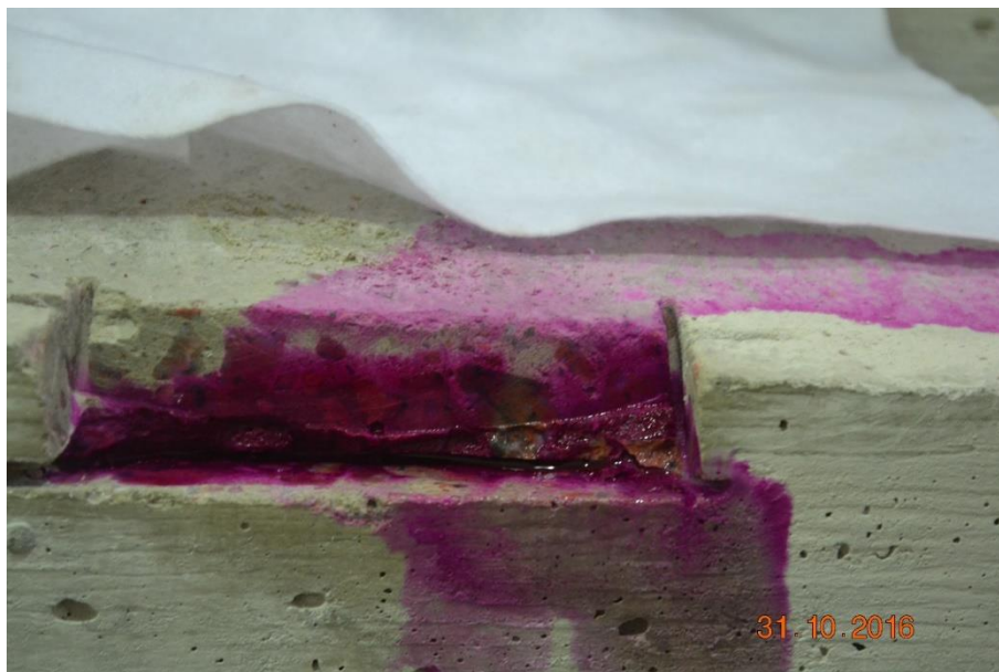
Figura 29 – Realcalinização química
