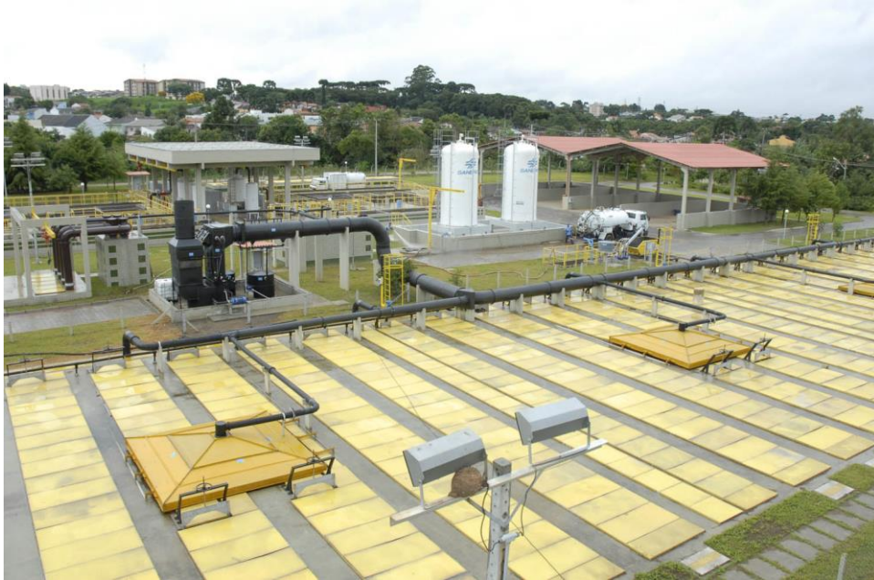
Figura 14: Reatores do tipo UASB
