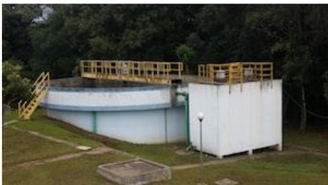
**Figura 9 – Adensador de lodo**
