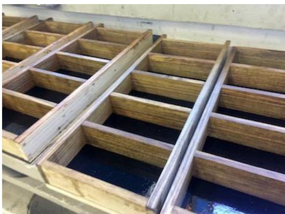
Figura 21 – Fôrmas em madeira e compensado
