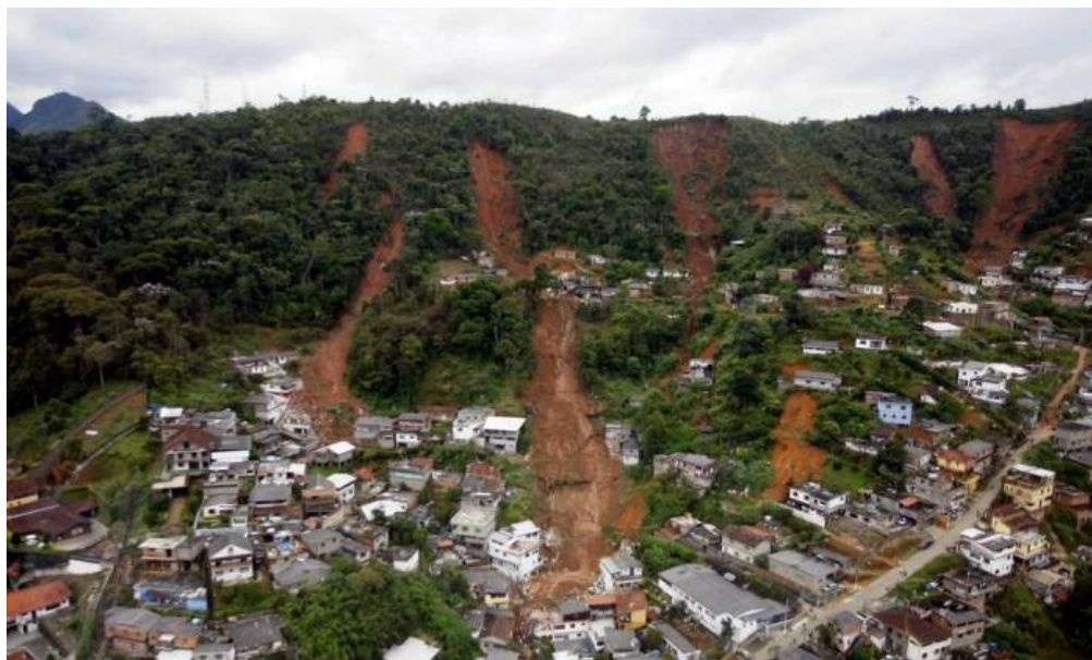
Figura 8 - Desastre da região serrana do Rio de Janeiro
