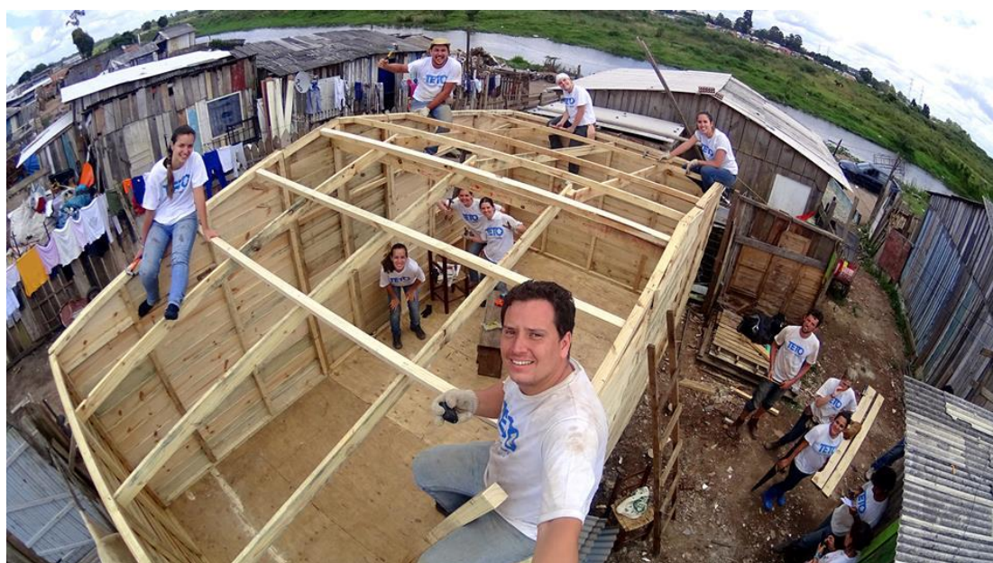
Figura 19 – Construção de moradia de emergência TETO
