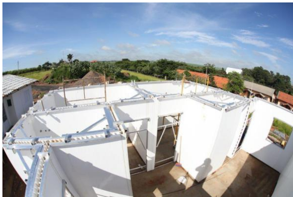
Figura 15 – Residência modular em aço
