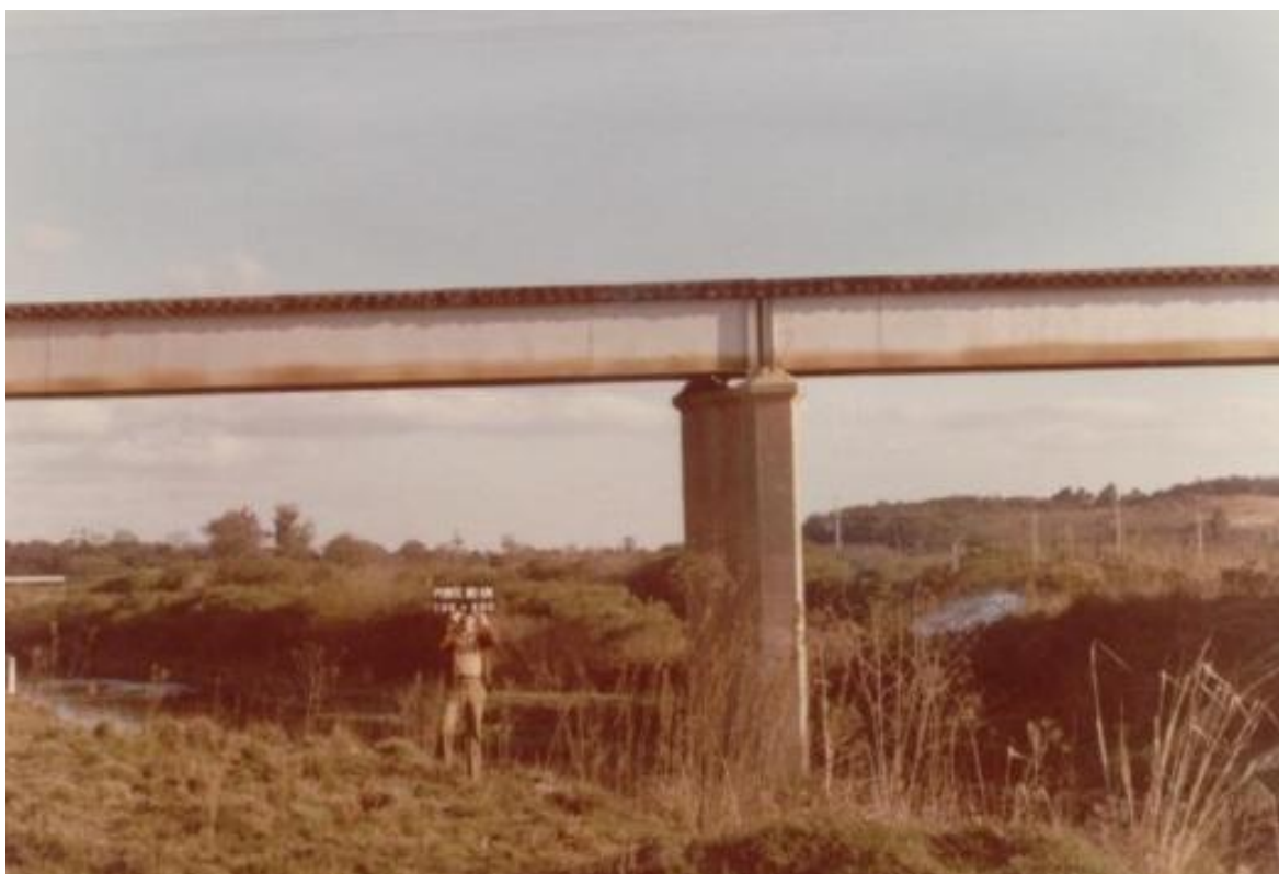
Figura 19: Vista Lateral Ponte Ferroviária do km 126+900 Fonte: RFFSA (1992)
