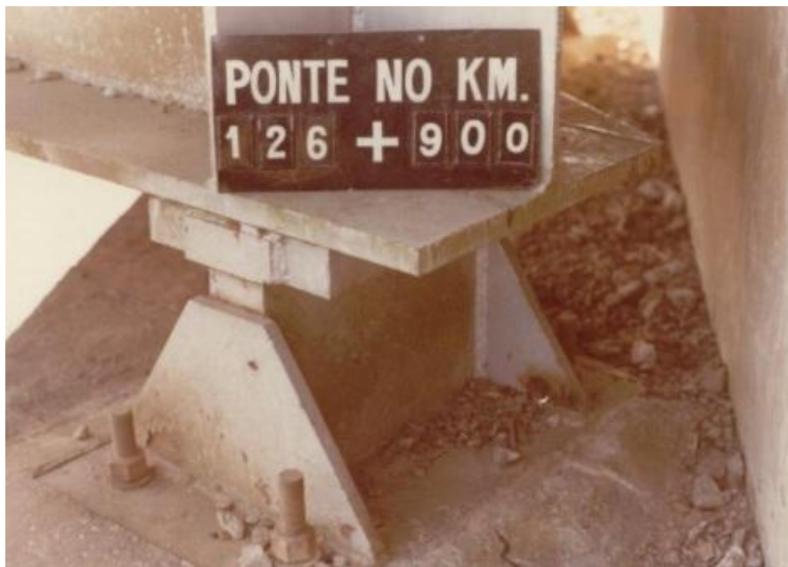
Figura 21: Apoio das Vigas de Aço da Ponte Ferroviária do km 126+900 Fonte: RFFSA (1992)
