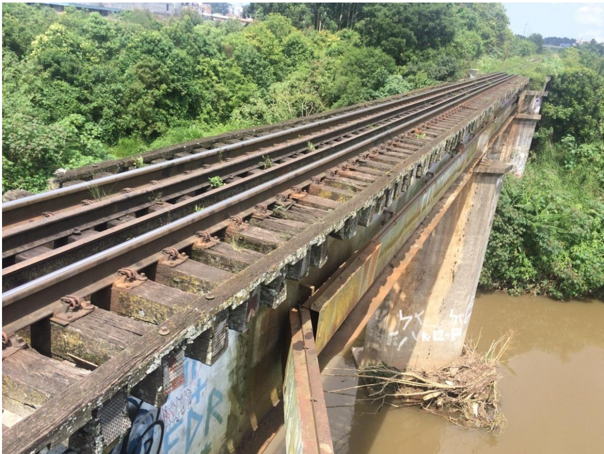
Figura 12: Ponte Ferroviária localizada no km 126+900 da ferrovia do Xisto. Fonte: Autor (2016)
