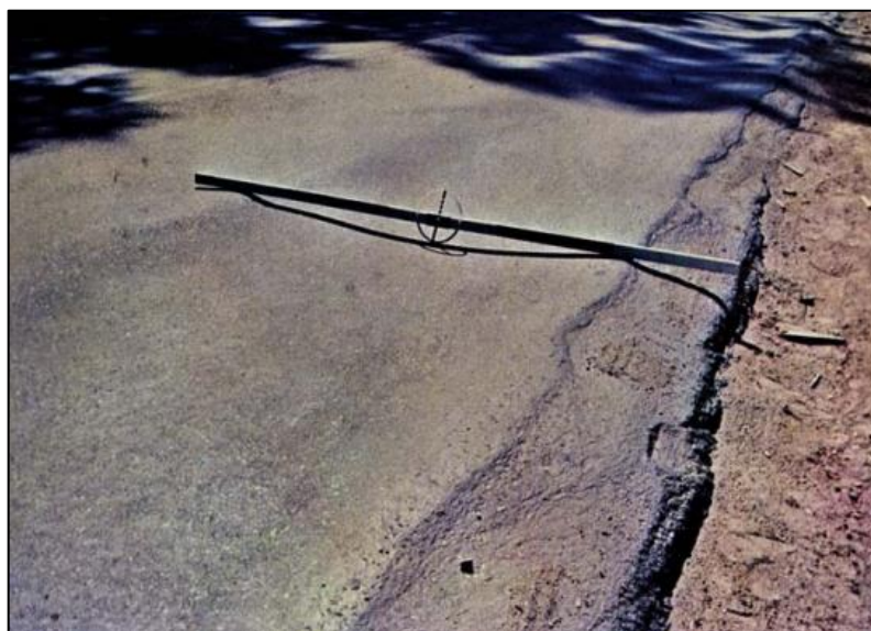
Figura 6 - Afundamento de Trilha de Roda Fonte: DNIT 005/2003
