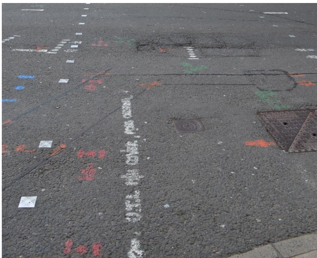
Figura 4 - Localização das redes subterrâneas marcadas sobre o pavimento em rua da cidade de Glasgow (Escócia, Reino Unido)
