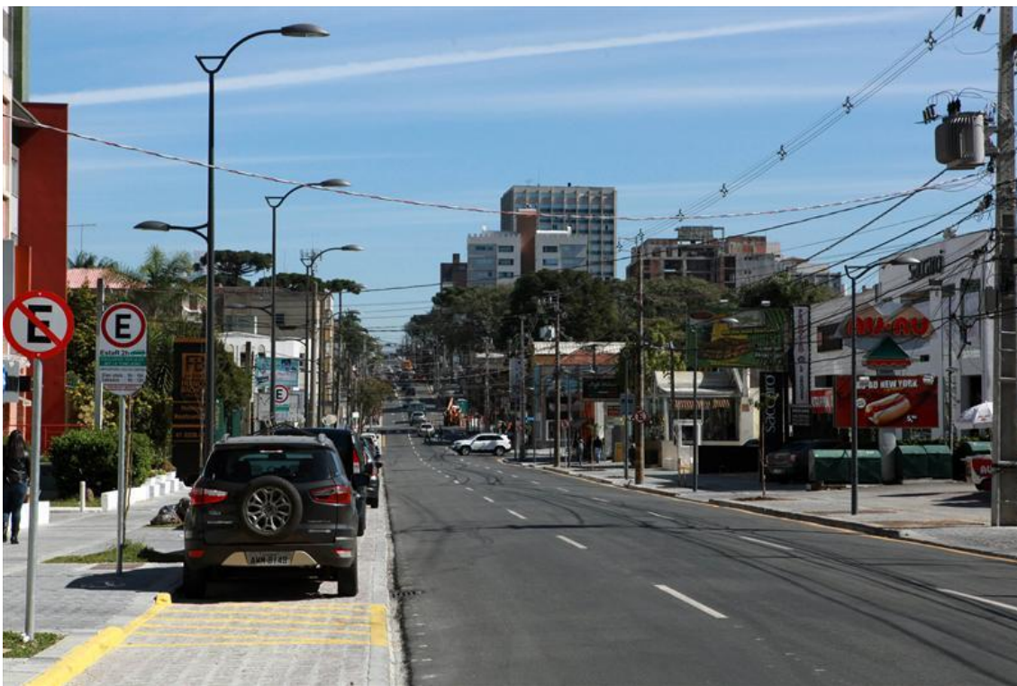
Figura 7 - Trecho revitalizado da Av. Dr. Carlos de Carvalho. Rede aérea de distribuição mantida do lado direito da via.
