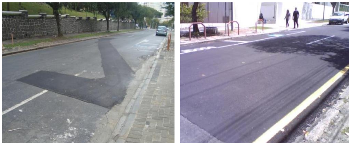
Figura 8 – Trecho de via pública onde foi exigida a recuperação total da pavimentação após a conclusão do serviço.
