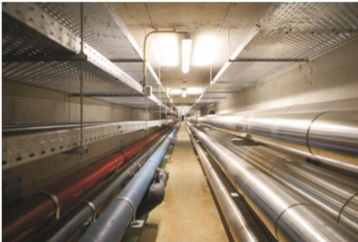
Figura 11 – Solução através da implantação de galerias técnicas
