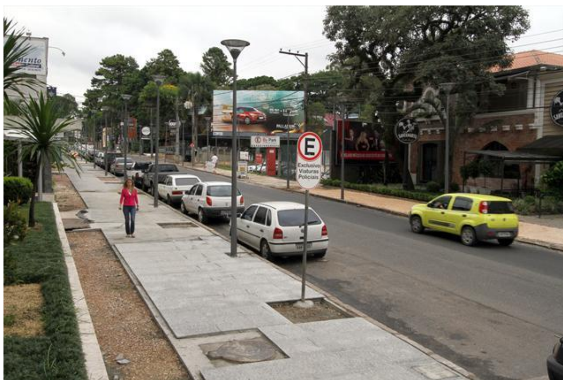
Figura 5 - Trecho revitalizado da Av. do Batel, ainda em fase de obras. Rede aérea de distribuição mantida do lado direito da via.
