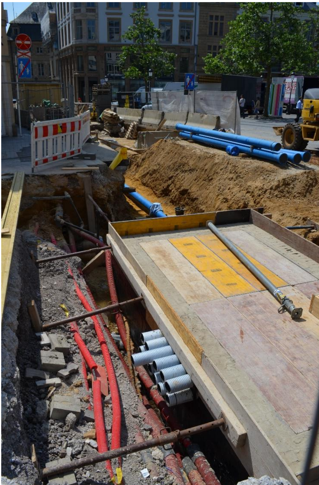
Figura 2 – Obras de modernização da rede subterrânea na região central da Cidade de Luxemburgo (Luxemburgo)
