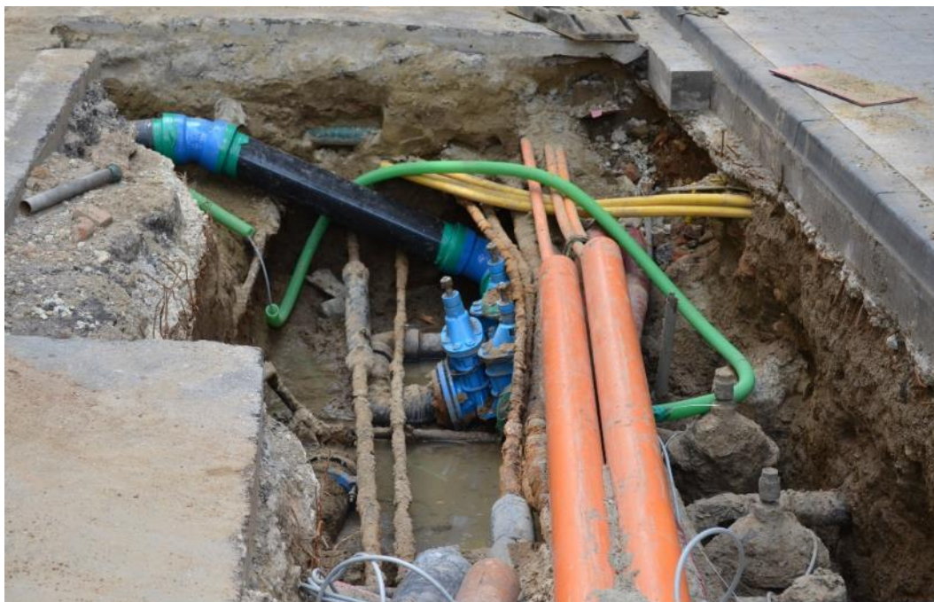
Figura 3 – Interferências observadas em escavação em via da cidade de Bruxelas (Bélgica) Fonte: Autoria própria
