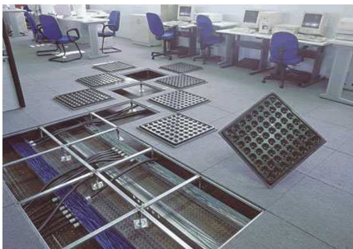
Figura 16 - Piso elevado em escritório Fonte: Sivic Pisos Elevados (2015)
