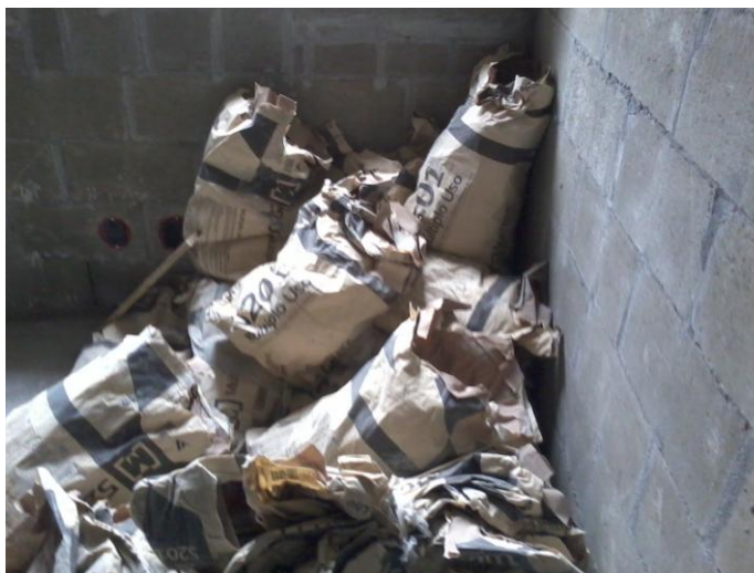
Figura 18 – Resíduo da embalagem de argamassa
