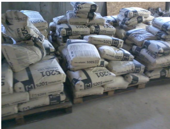
Figura 17 – Armazenamento da embalagem de argamassa
