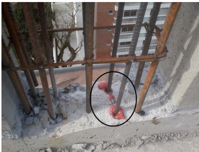
Figura 21 – Utilização do adesivo epóxi
