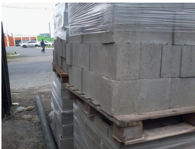
Figura 12 – Armazenamento de blocos nos pallets
