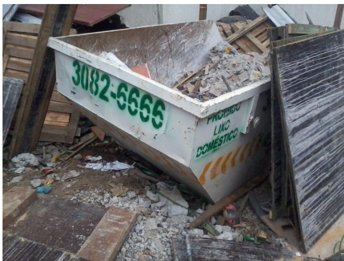
Figura 10 – Caçamba para retirada de entulho
