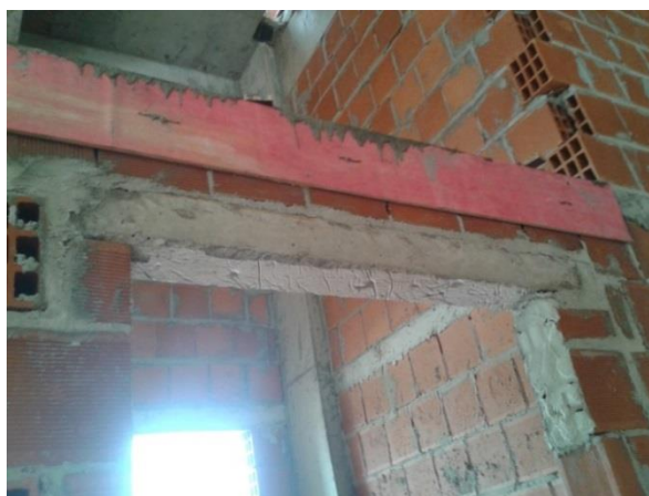
Figura 14 - Reaproveitamento de madeiras utilizadas em outras etapas
