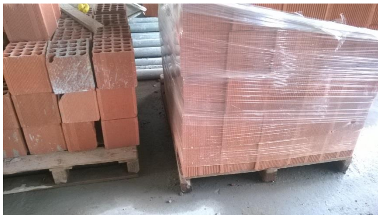
Figura 15 - Armazenamento de blocos em pallets
