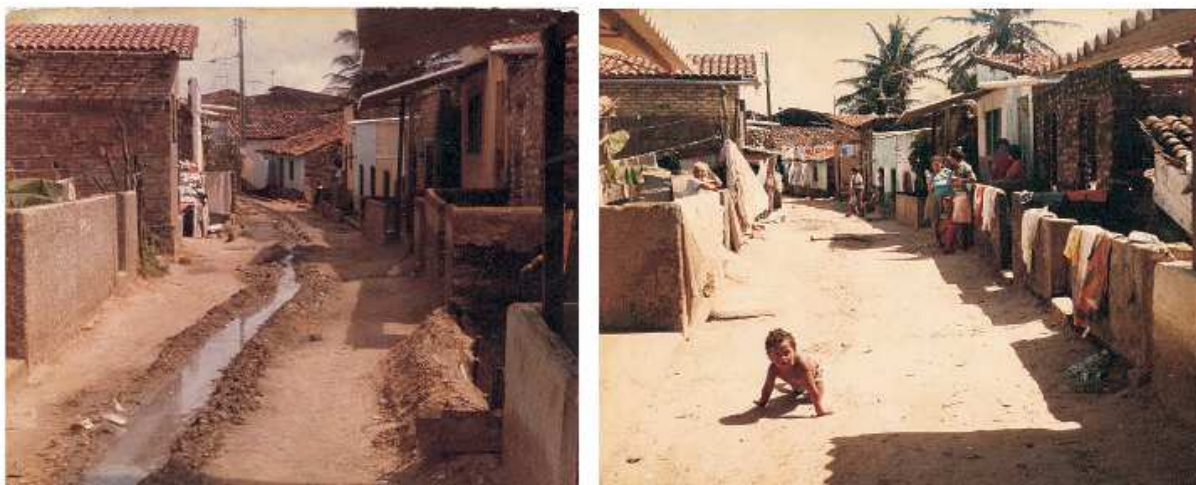
Figura 12 - Rua antes (esquerda) e depois (direita) da rede condominial. Fonte: MELO (2008, p. 153).
