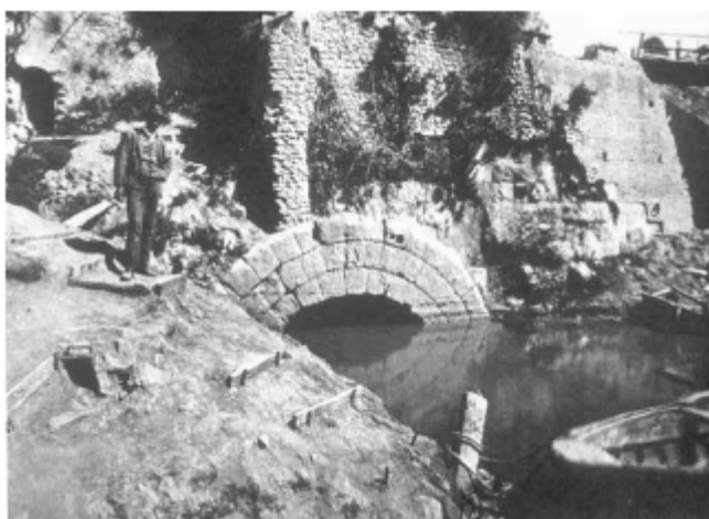
Figura 1 - Boca de descarga da cloaca máxima. Fonte: REZENDE E HELLER (2002, p. 132).
