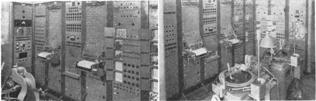
Figura 1 – Imagem do Music Synthesizer Mark I, da RCA Corporation.
