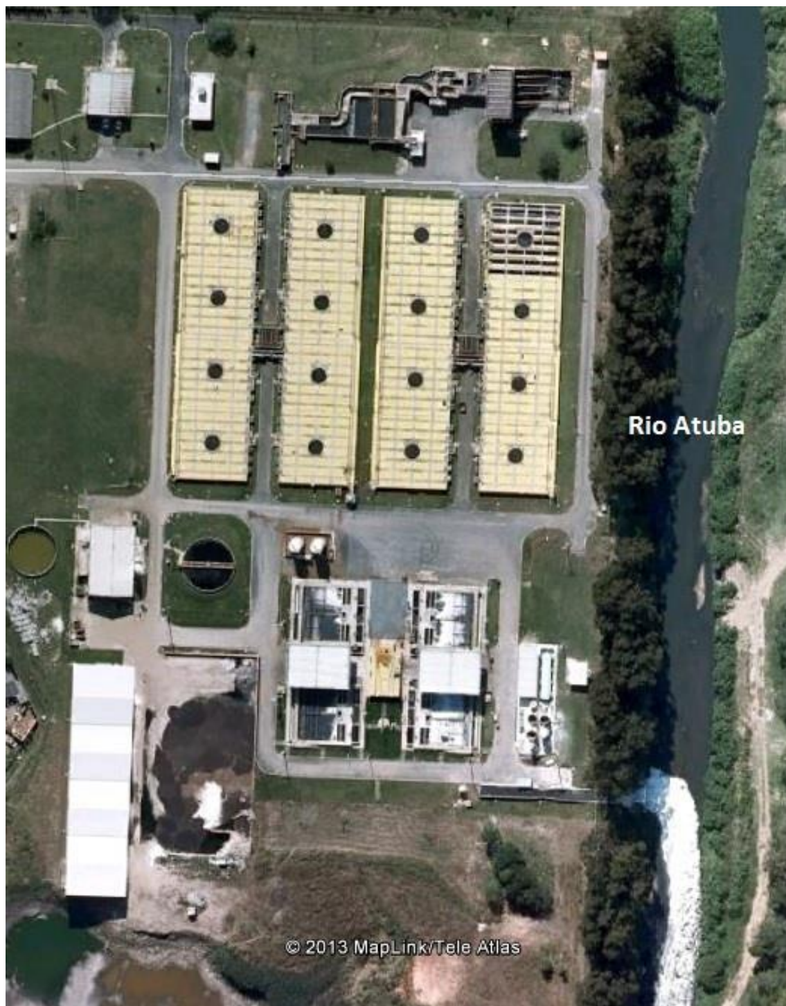
Figura 1. Estação de tratamento de esgotos Atuba-Sul Fonte: Google Earth, 2013.
