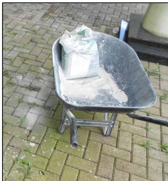
Figura 15 - Argamassa para vedação das juntas em paredes de drywall . Fonte: Autoria própria.
