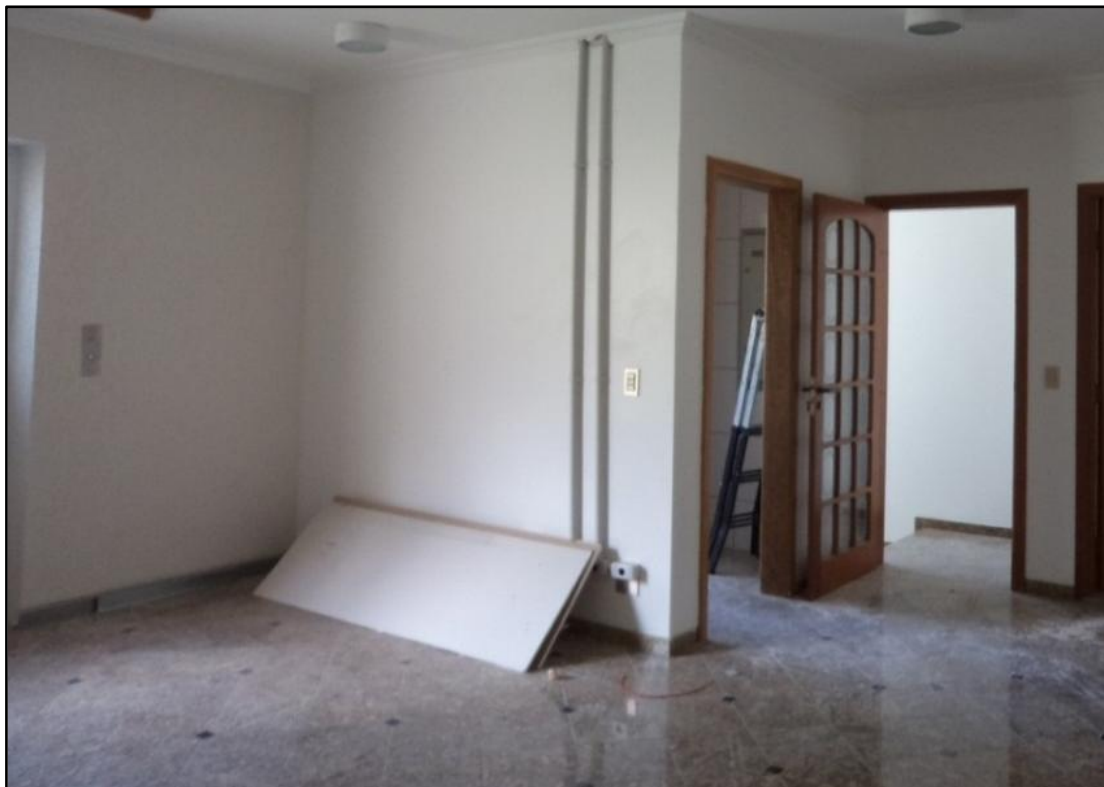
Figura 12 - Estocagem das chapas de gesso. Fonte: Autoria própria.
