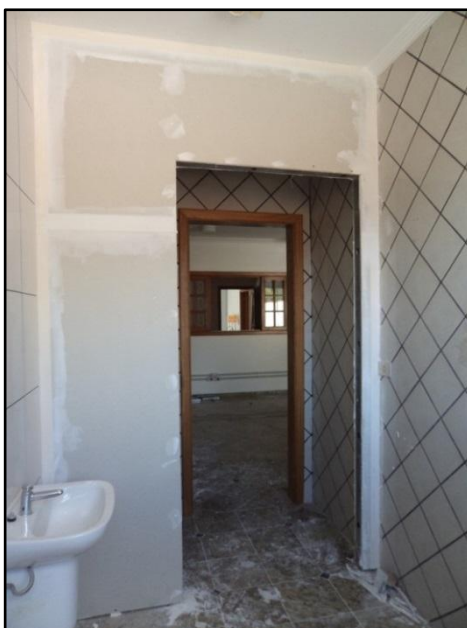
Figura 11 - Divisória em drywall . Fonte: Autoria própria.
