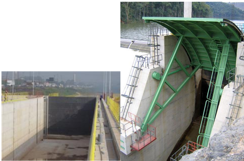
Figura 19- Comporta ensecadeira (esquerda) e comporta segmento (direita) Fonte: Hacker (2013).
