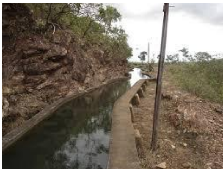
Figura 8 - Canal de adução aberto Fonte: CERPCH (2009).
