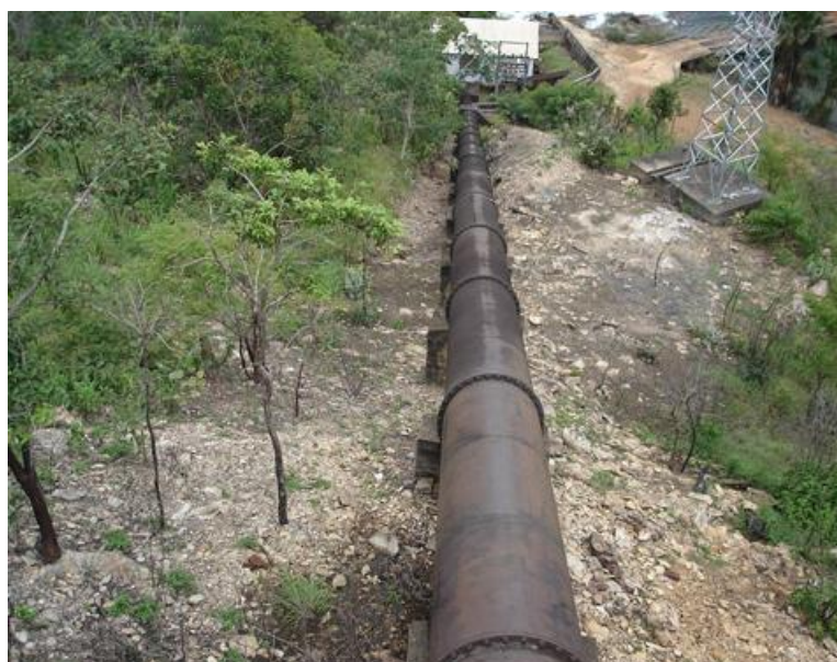
Figura 11- Conduto forçado. Fonte: CERPCH (2009).
