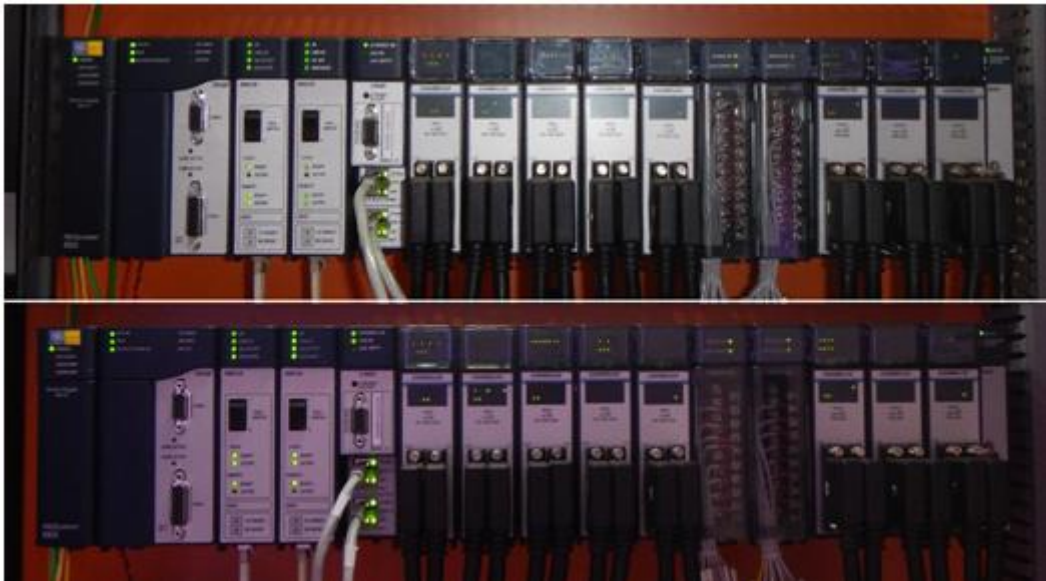
Figura 8 - CLPs em redundância Fonte: Autoria Própria
