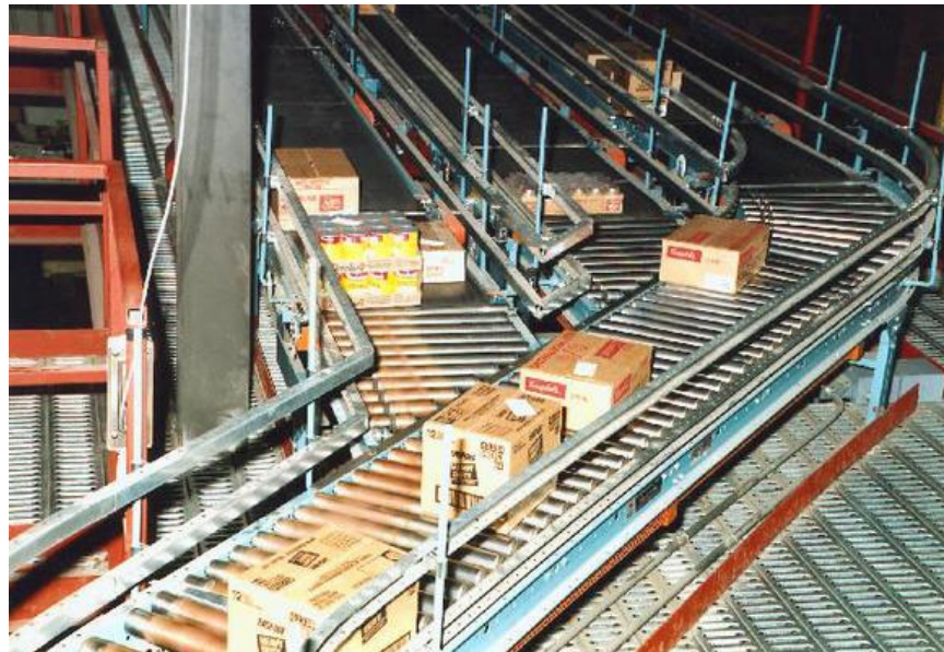
Figura 3 - Sistema conveyor Fonte: Sistema de distribuição (2015)
