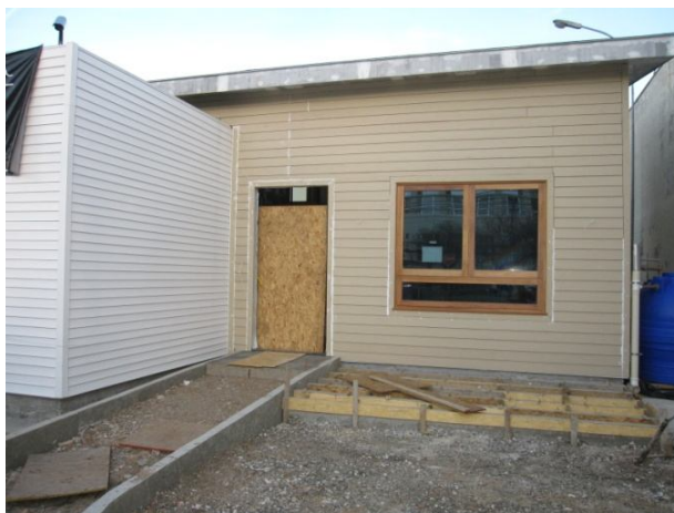
Figura 13 - Construção física do Escritório Verde - Colocação dos materiais ofertados FONTE: Arquivo TECVERDE, 2011.
