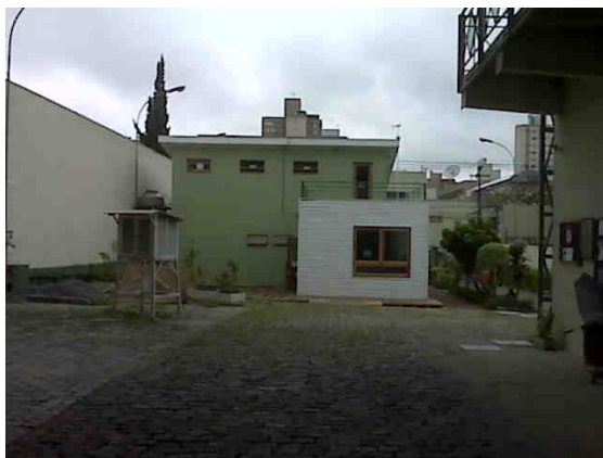
Figura 18 - Construção física do Escritório Verde concluída – vista fundos
