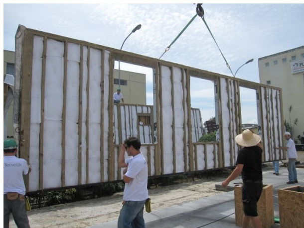
Figura 8 - Construção física do Escritório Verde - Colocação dos materiais ofertados FONTE: Arquivo TECVERDE, 2011.
