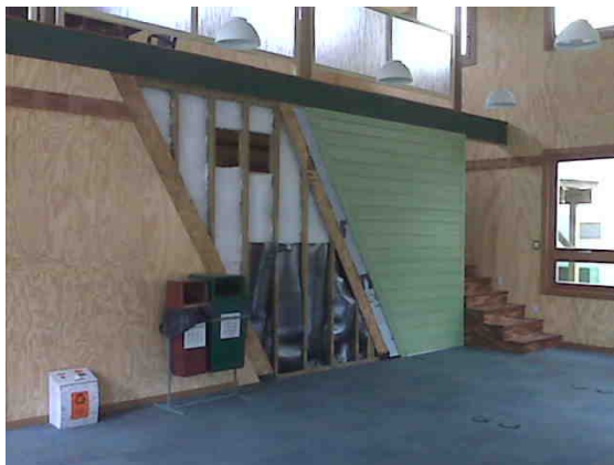
Figura 20 - Construção física do Escritório Verde concluída – vista interna, demonstração dos materiais aplicados.
