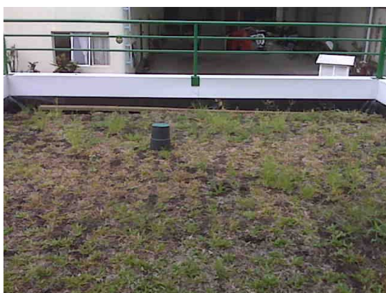
Figura 23 - Construção física do Escritório Verde concluída – telhado verde
