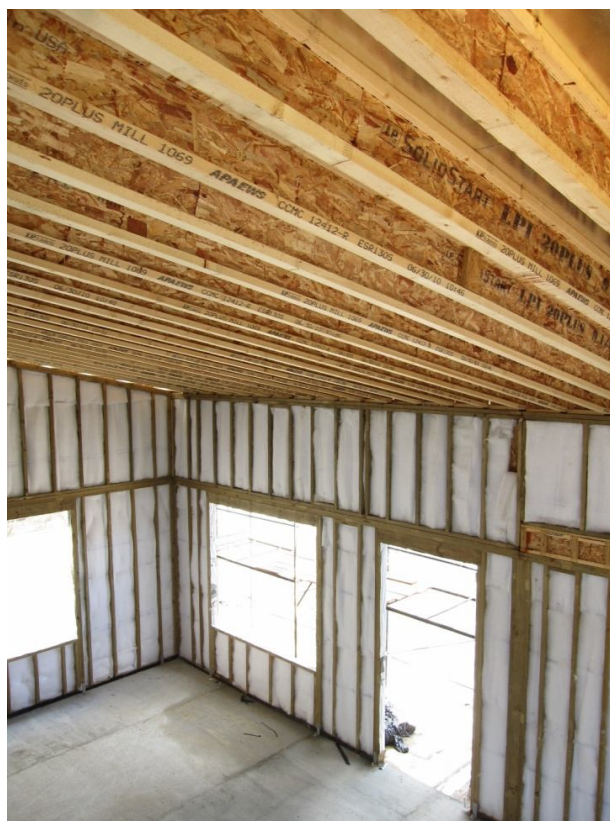
Figura 9 - Construção física do Escritório Verde Colocação dos materiais ofertados FONTE: Arquivo TECVERDE, 2011.
