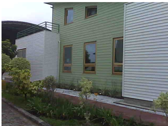
Figura 15 - Construção física do Escritório Verde concluída – vista lateral
