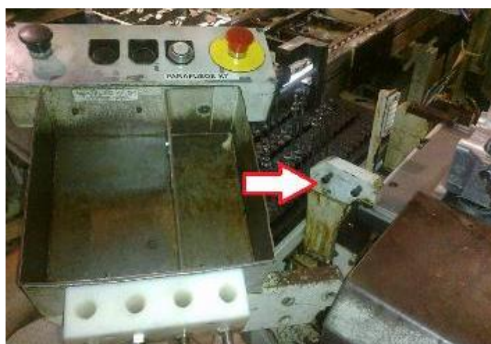
Figura 42- Fixação da caixa de botoeiras. Fonte: Autoria própria.
