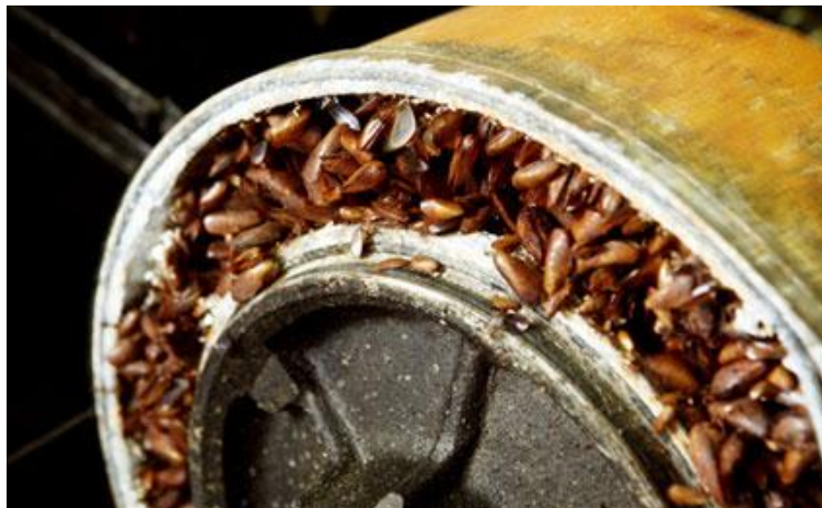
Figura 8. Mexilhão – Dourado nas turbinas de Itaipu Fonte: ITAIPU, 2010
