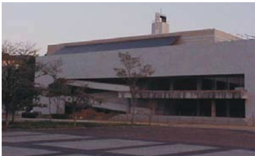
Figura 14 – Centro de Exposições da UFSC, com SFV de 10 kWp integrado a parte da cobertura da edificação.
