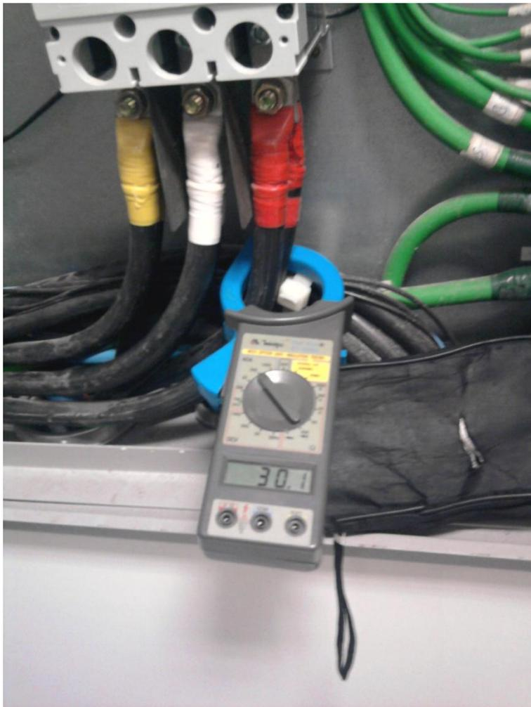
**Figura 40 - Detalhe do alicate amperímetro durante o processo de medição**
