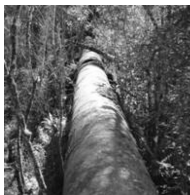
(b) – Conduto forçado
