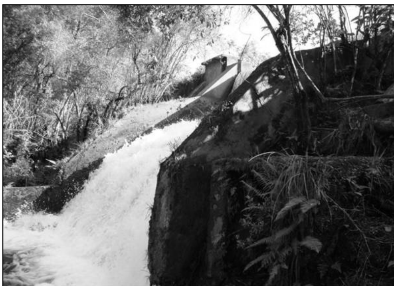
Figura 1 – Barragem e vertedouro da Usina Roncador Fonte: Própria.
