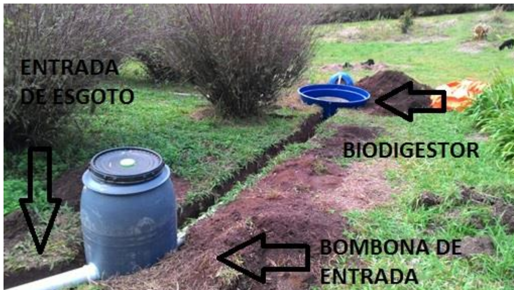
Figura 6 - Ligação bombona de carga de 250 l. Fonte: Própria.
