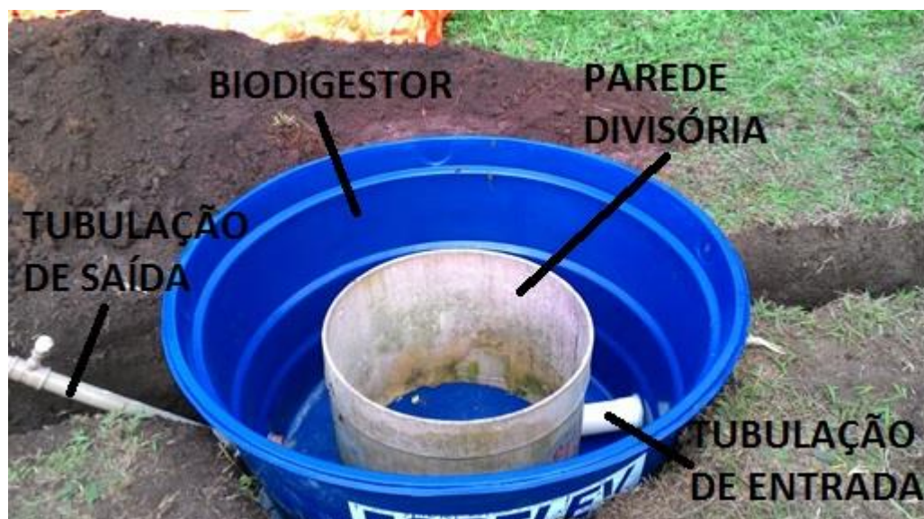
Figura 7 - Biodigestor – Caixa d'água de 1000 l. Fonte: Própria.
