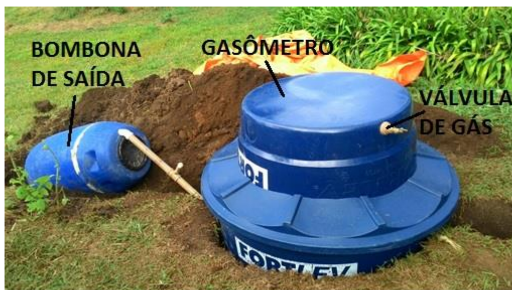
Figura 8- Biodigestor – Com gasômetro e válvula de saída de gás instalada. Fonte: Própria.
