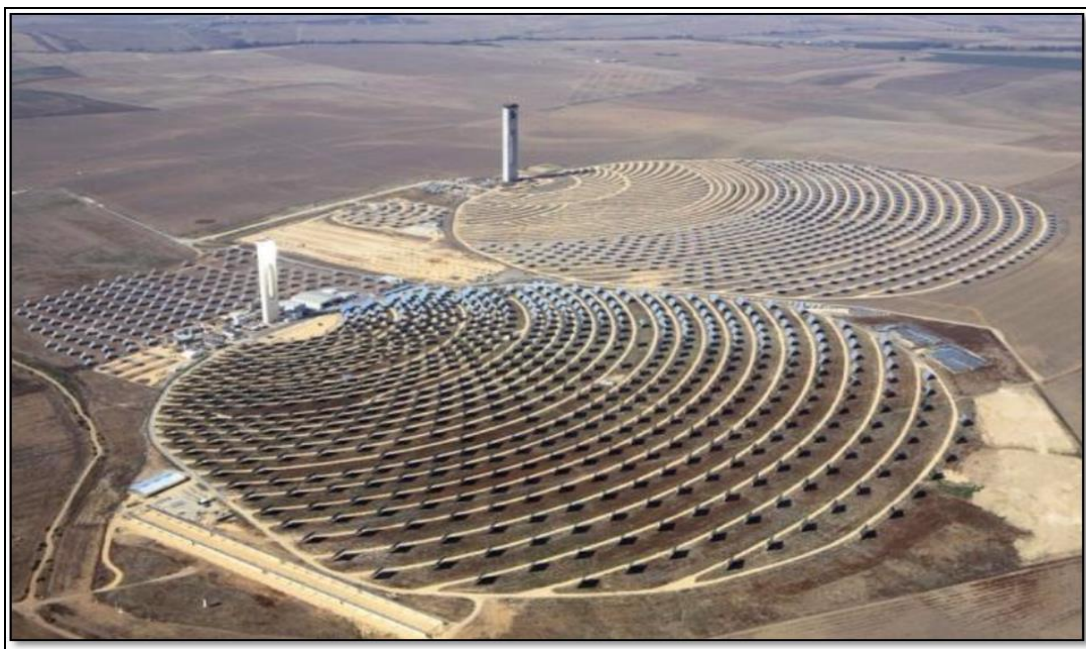
Figura 11: Planta CSP Torre Solar, instalada na Espanha, contando com 624 heliostatos. Fonte: GIZ, 2014
